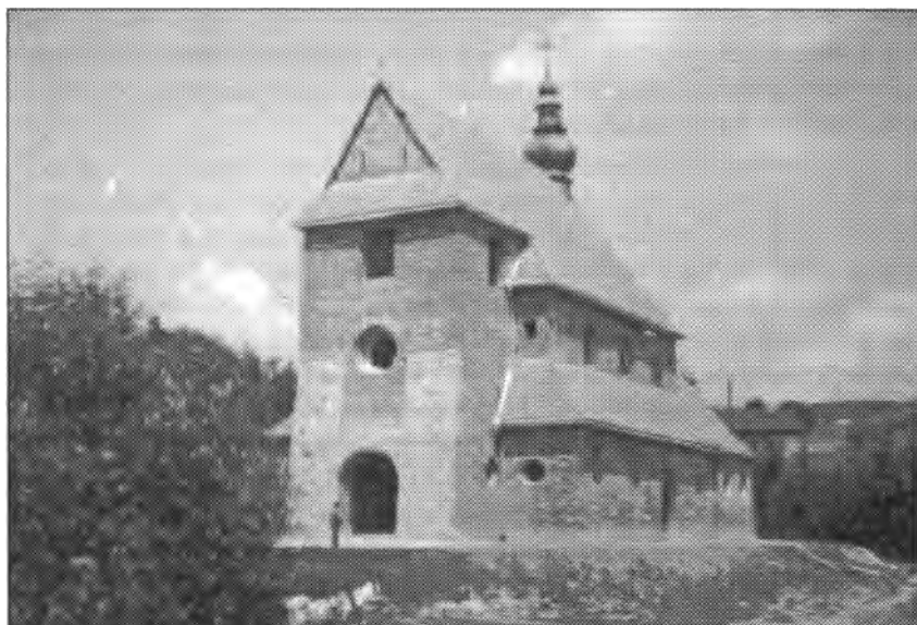
Kościół w Paszynie w budowie. Zdjęcie ze zbiorów rodziny Remich
