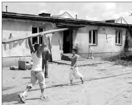
Likwidacja baraków przy ul. Zawiszy Czarnego
