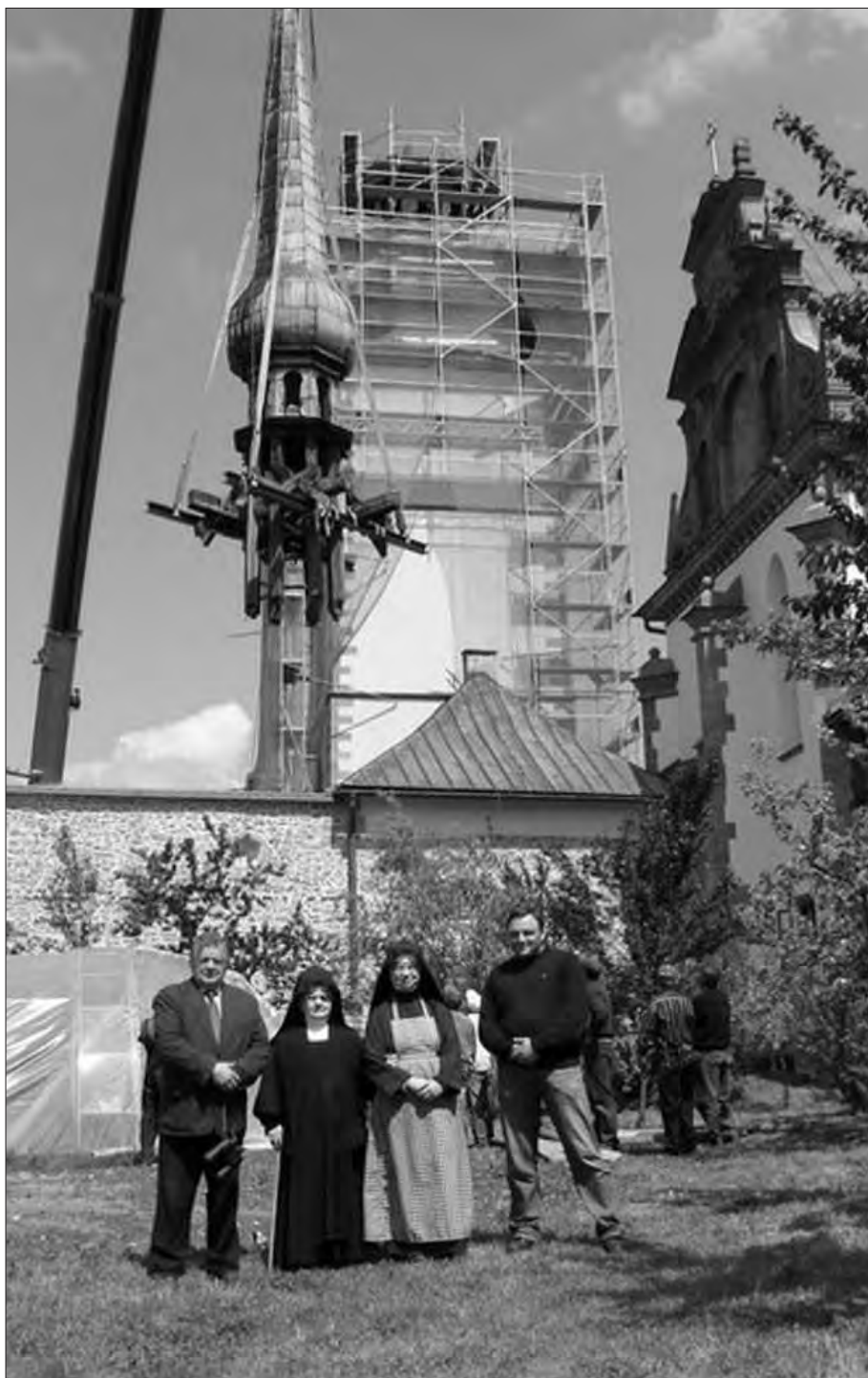
Remont wieży bramnej klasztoru Klarysek, 2010 r.
