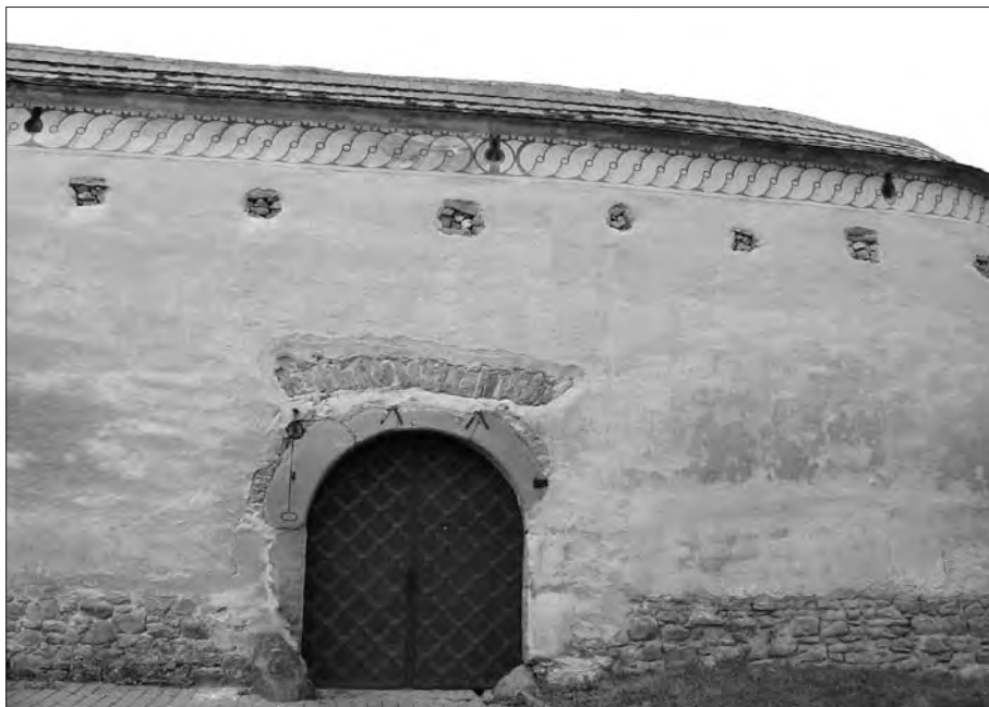
Brama gospodarcza w murze klasztornym. Stan przed remontem generalnym w 2009 r.
