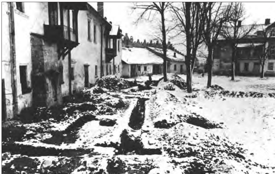
Dziedziniec zamkowy w czasie odbudowy zamku, przełom lat dwudziestych i trzydziestych ubiegłego wieku
