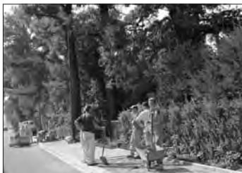
Remont ul. Nawojowskiej
