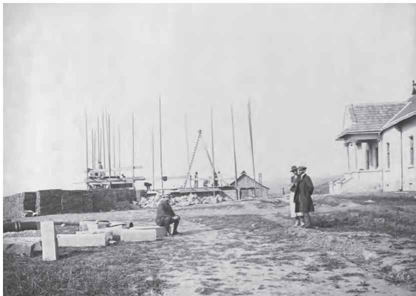
Budowa zakładu pomp w Świniarsku
