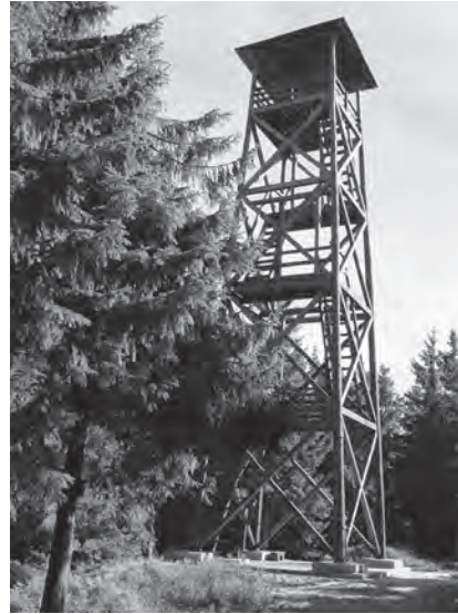
Wieża widokowa na szczycie Radziejowej – zrealizowana w ramach projektu „Ochrona walorów przyrodniczych Doliny Roztoki Wielkiej”
