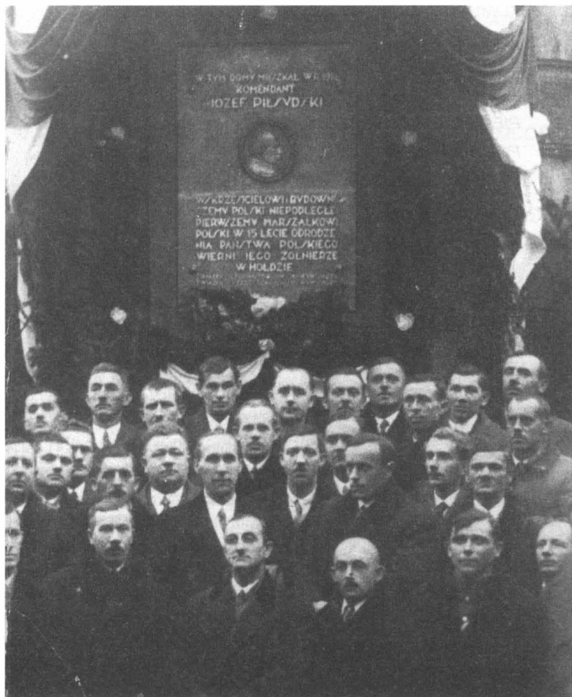
Odślonięcie w Nowym Sączu tablicy poświęconej Józefowi Piłsudskiemu na narożu kamienicy przy ul. Juliana Dunajewskiego, 11 listopada 1933 r.
